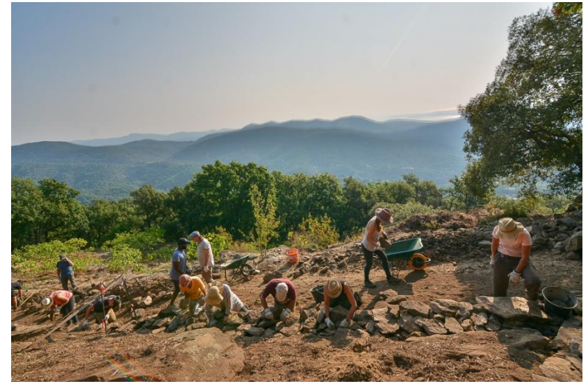
Construction d'un mur en pierre sèche Conservatoire Freinet
