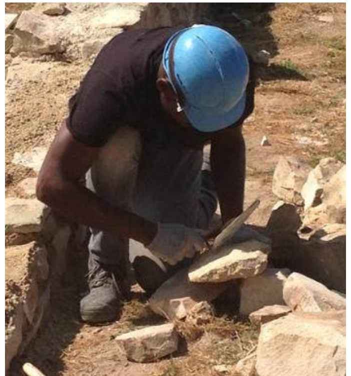
Chantier de Rambouillet, 2018 - REMPART
