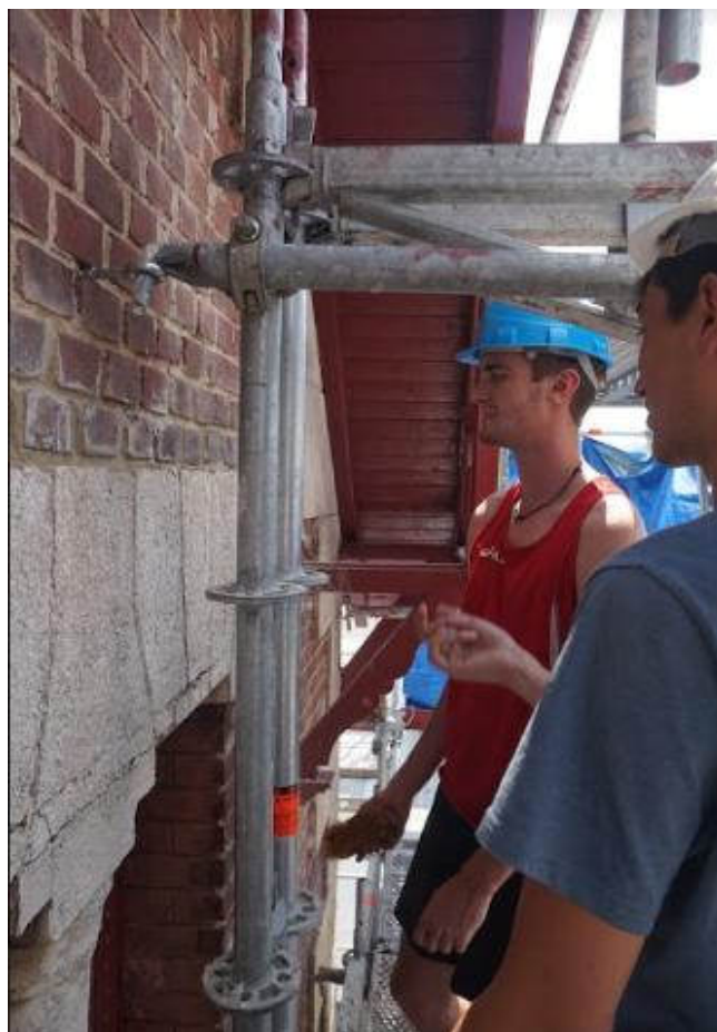
Chantier de Chelles, 2018 - REMPART
